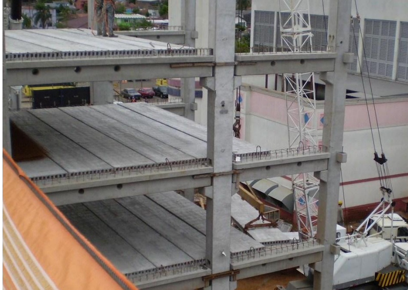
Figura 7: diferentes seções transversais de lajes alveolares e a colocação por guindaste em Canoas
