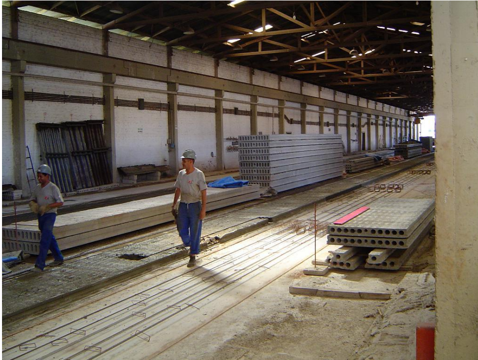
Figura 10: pista de extrusão de uma fábrica de lajes alveolares em Porto Alegre
