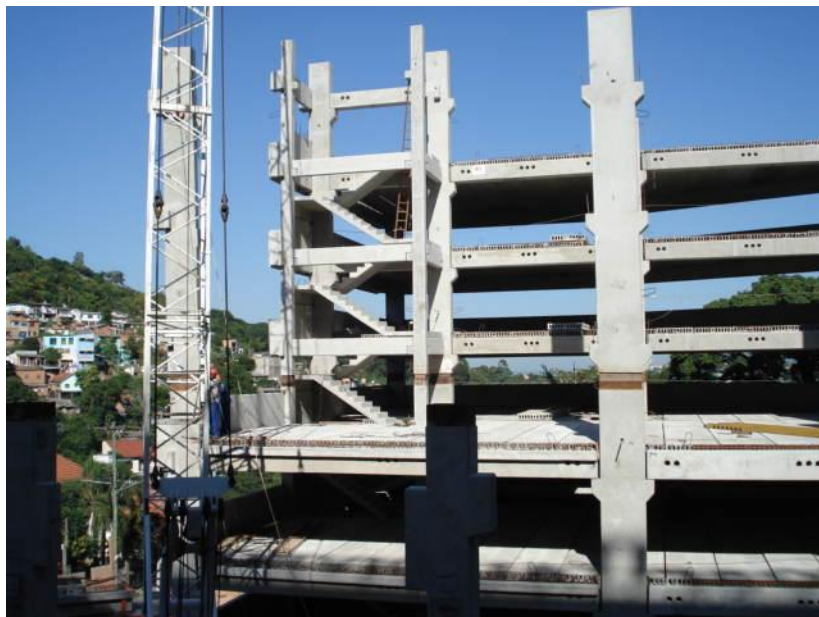
Figura 1: construção com peças pré-fabricadas em Porto Alegre
