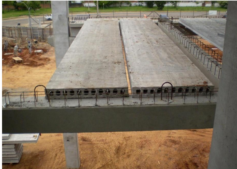
Figura 6: laje alveolar em fase inicial de montagem em obra em Canoas
