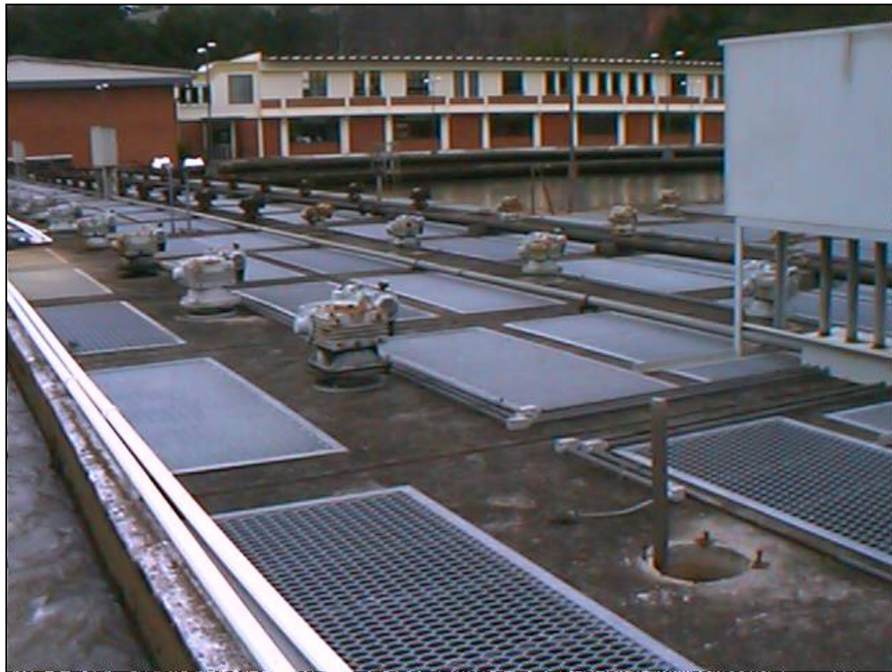
Figura 4: unidade de floculação ETA José Loureiro da Silva, Porto Alegre/RS
