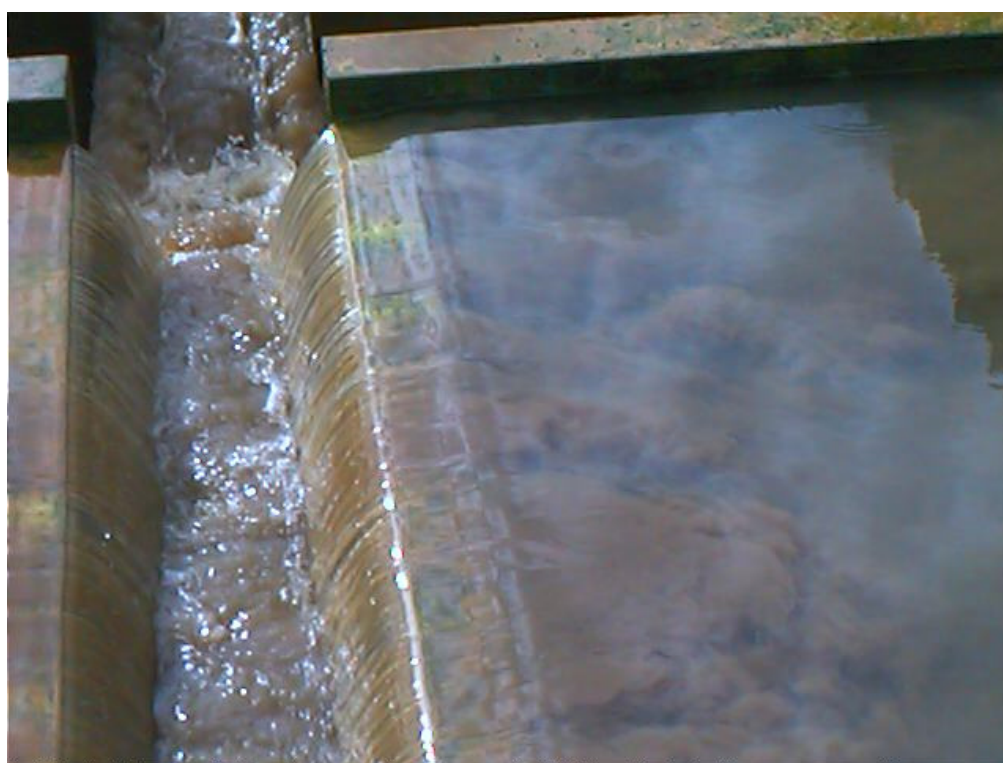
Figura 16: impurezas sendo encaminhadas para as calhas de coleta na ETA Menino Deus, Porto Alegre/RS
