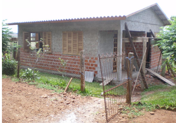
FIGURA 12 - CASA NOVA EM CONSTRUÇÃO (DADOS DE CAMPO, 2010)
