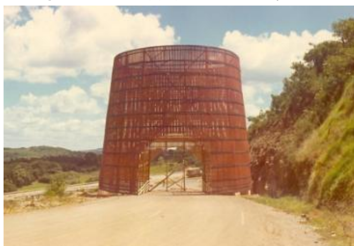
Figura 17 - Primeira pipa pórtico em construção, 1975
