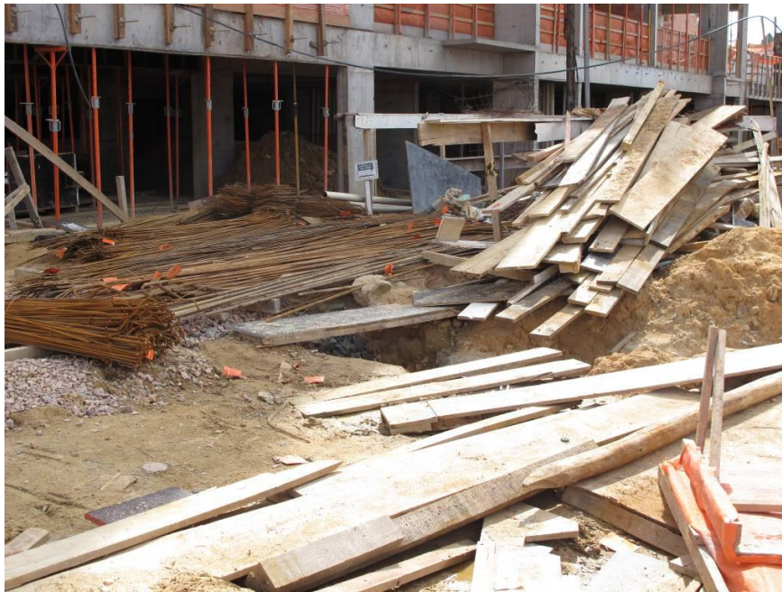
Figura 17 – Armazenamento de aço e madeira
