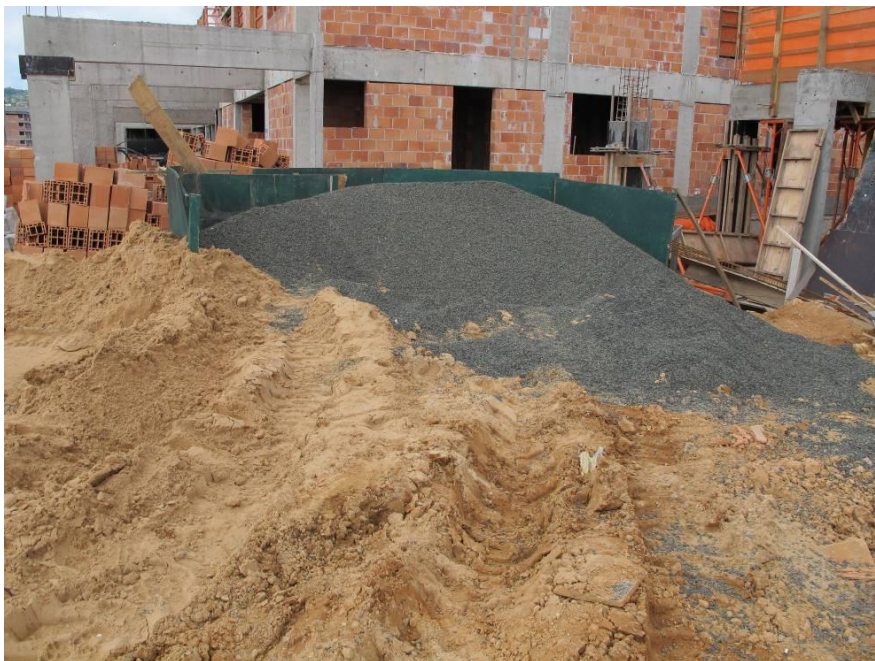
Figura 19 – Armazenamento de areia e brita
