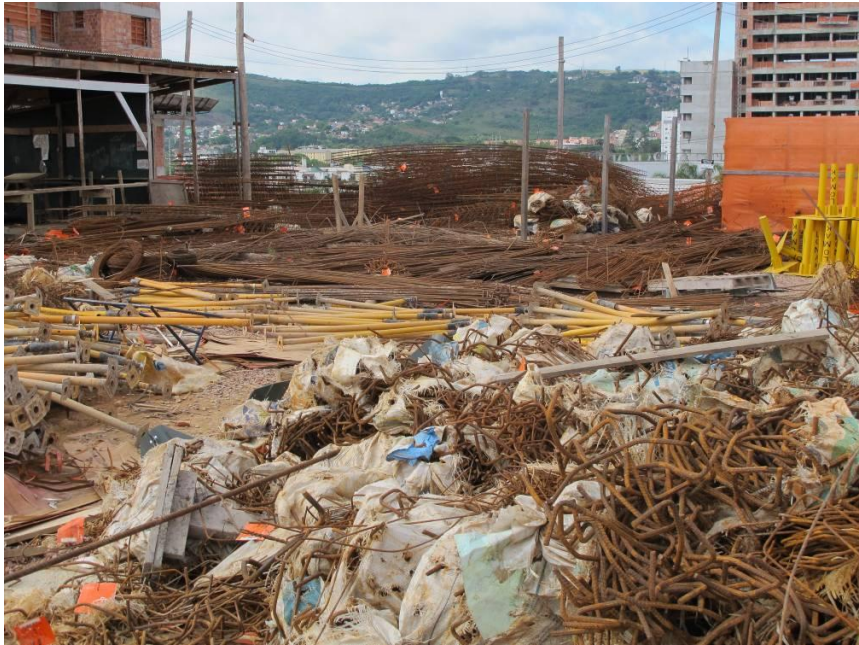
Figura 18 – Armazenamento de aço, escoras e tubos de linha de vida
