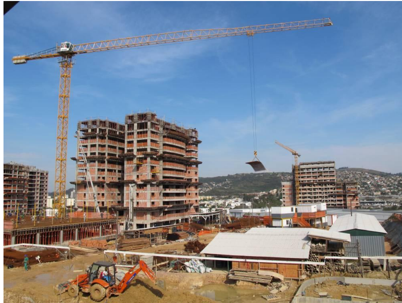
Figura 15 – Movimentação de telas de aço
