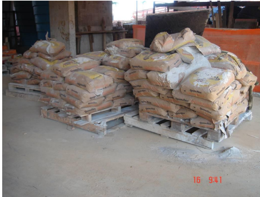
Figura 20 – Armazenamento de argamassa
