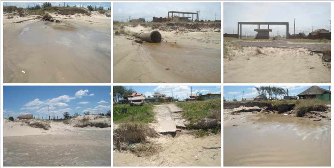
Figura 32: Mosaico de fotos mostrando a situação do trecho – sangradouro artificial com estruturas inapropriadas, asfalto no local das dunas frontais, trilhas sobre as dunas e retirada das dunas dando lugar a construções.
