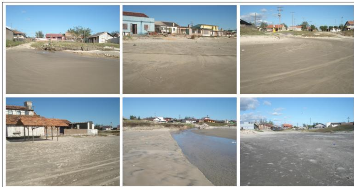
Figura 16: Mosaico de fotos representando a situação do trecho – sangradouros inapropriados, aberturas de acesso a beira mar e construções a beira mar sem a proteção das dunas frontais.
