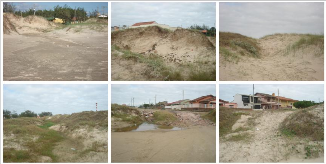
Figura 18: Mosaico de fotos mostrando a situação do trecho – brechas nas dunas, presença de resíduos de construção nas dunas, cobertura vegetal esparsa e abertura de rua
