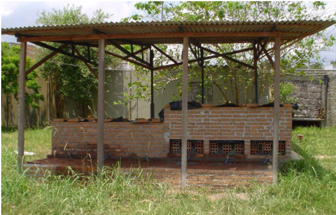
Figura 4.3: Estrutura dos leitos de secagem em alvenaria.
