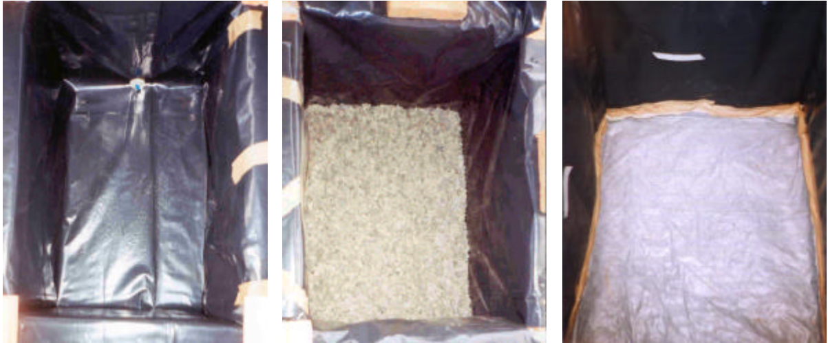
Figura 4.5: Montagem dos leitos convencionais: (a) lona revestindo o fundo e as paredes laterais internas do leito; (b) brita colocada sobre a lona, cobrindo o dreno de fundo; (c) bidim colocado sobre a brita.
