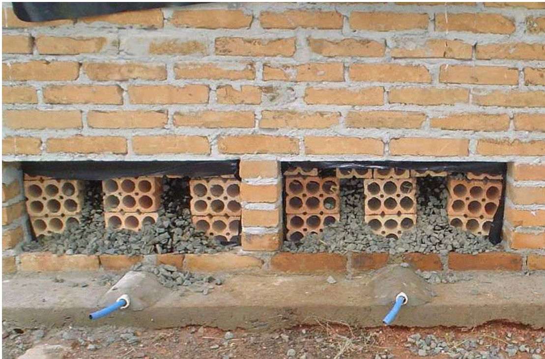
Figura 4.7: Aberturas laterais nos leitos modificados.
