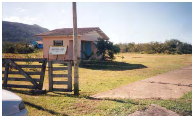
Figura 16 - Casa de Manutenção
