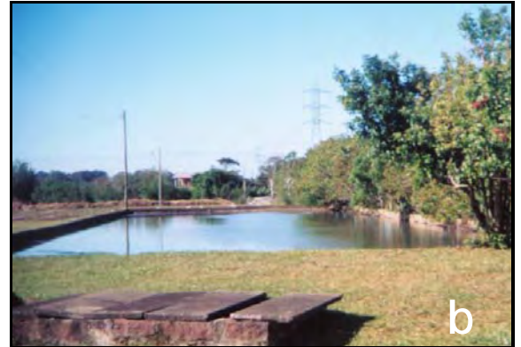
Figura 12 - Aspecto construtivo da Bacia de Decantação: (a) em 1998; (b) situação atual (2004).
