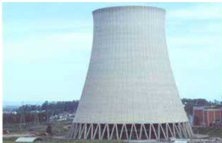
Figura 1.1: Torre de resfriamento
