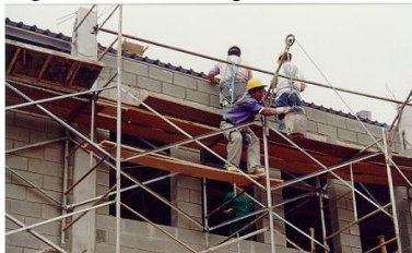
Figura 5.14 - Transporte do balde com corda
