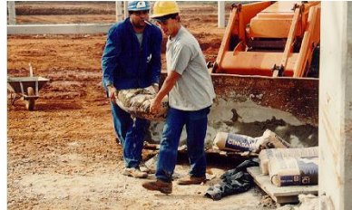
Figura 5.11 - Transporte manual até estoque intermediário próximo a betoneira
