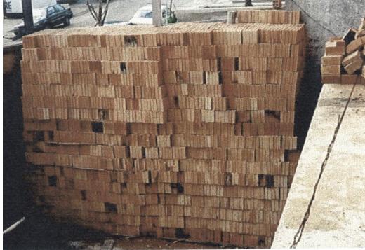
Figura 5.1 - Estoque de blocos cerâmico ultrapassando a altura de pé-direito
