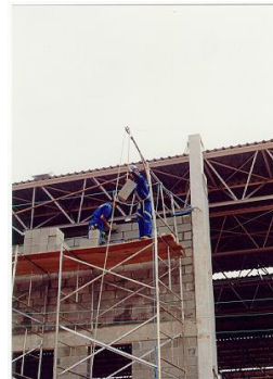
Figura 5.15 - Transporte do bloco com corda
