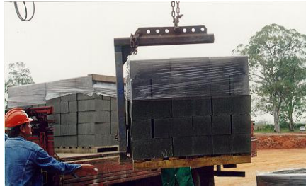
Figura 5.6 - Transporte com caminhão com guindaste
