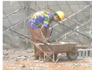
Figura 5.13 - Transporte a colher para o balde
