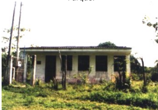
Figura 5.6: Foto do posto de saúde (abandonado) localizado na comunidade Barra do Superagui, que concentra a maior parte da população residente na parte insular do Parque.
