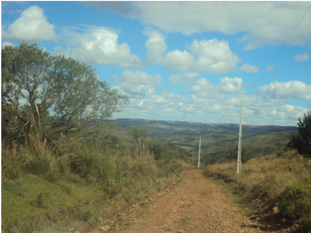
Figura 5 – Energia elétrica na zona rural, localidade Canheca, município de Jaquirana, RS Fonte: Fotografia da autora (maio/2011).
