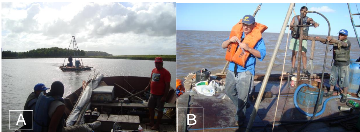
Figura 6. (A) - Balsa montada com o equipamento SPT, sendo rebocada até o local de execução do furo de sondagem; (B) Equipe trabalhando na execução do furo de sondagem.
