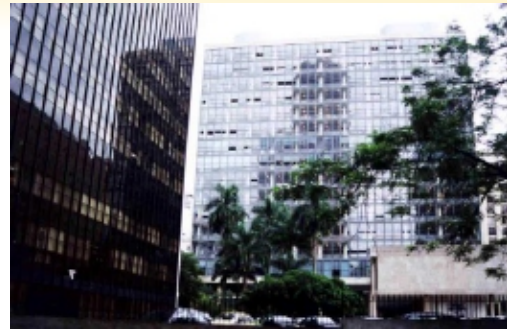
FIGURA 37 - A fachada sul contraposta à um novo prédio, situado absurdamente na explanada do Ministério, na década de 70, anos de ferro da política brasileira;
