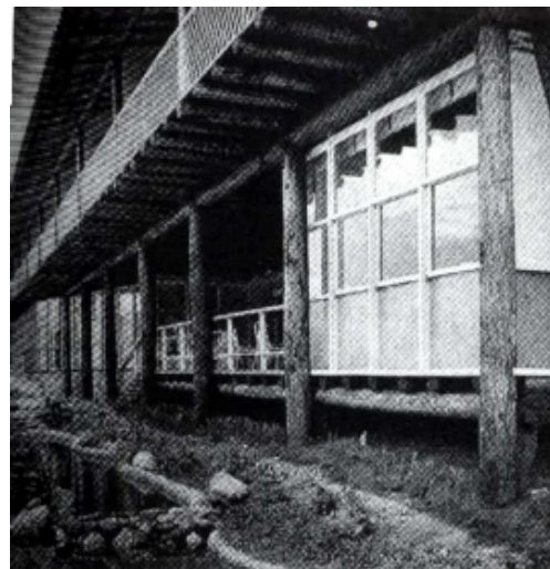
FIGURA 93 - Elevação a NW - o pilotis e a "laje nervurada" em toras de madeira. Foto da década de 50;
