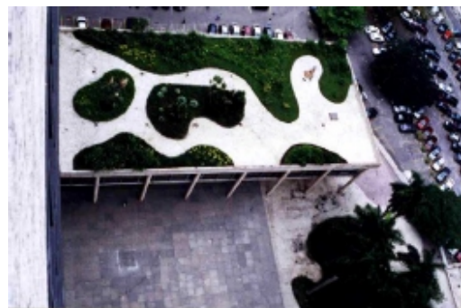
FIGURA 63 - A tecnologia do concreto armado e das impermeabilizações a serviço da arquitetura;
