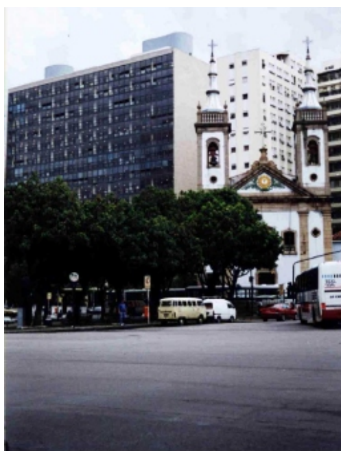
FIGURA 35 - Vista da fachada sul, envidraçada, e o contraste com a pré-existência - a arquitetura barroca que lhe serviu de inspiração;
