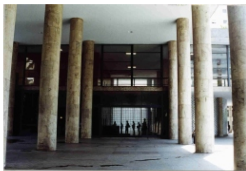
FIGURA 46 - A ocupação de parte do pilotis, no cruzamento em "T" da barra dominante vertical com a baixa, alongada do auditório e salão de exposições. Tecnologia estrutural e arquitetura encontram-se;
