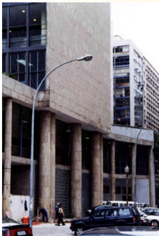
FIGURA 42 - A empena lateral, onde o Engenheiro Emílio Baumgart recomendava que fosse, cega, até o chão, resolvendo o problema de contraventamento, mas, para adotar-se uma solução estrutural "arquitetônica", adotou-se esse reforço de colunas como se vê na foto;
