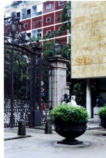
FIGURA 119 - O antigo portão de entrada do parque transformou-se em portal, simbolicamente, da relação passado e futuro, neo-clássico e moderno convivendo harmoniosamente; - detalhe da empena lateral do Bristol em pedra goiana e o pilotis;
