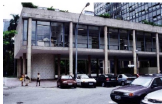
FIGURA 40 - O tema da colunata, no salão ganha outra versão, menos severa, jônica, indicando seu caráter. Ao mesmo tempo a precisão estrutural, a conciliação entre forma e tecnologia;
