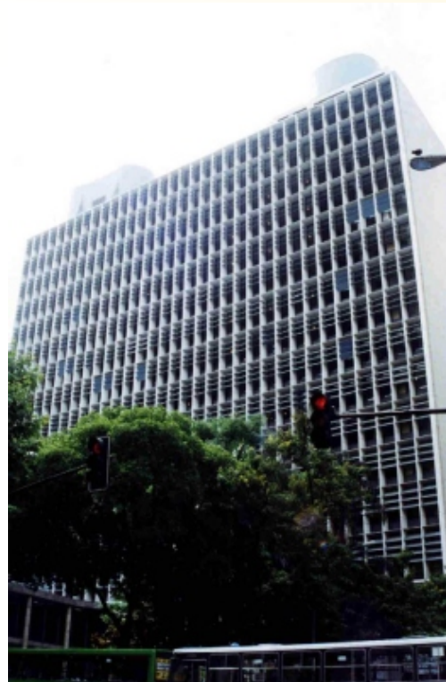
FIGURA 59 - Elevação norte com os "quebra-sol" formando a "grelha", proteção mista. No encabeçamento as formas metafóricas das chaminés dos transatlânticos dos anos 30, incorporando outra expressão para um elemento técnico, a torre de casa de máquinas e do reservatório d'água;
