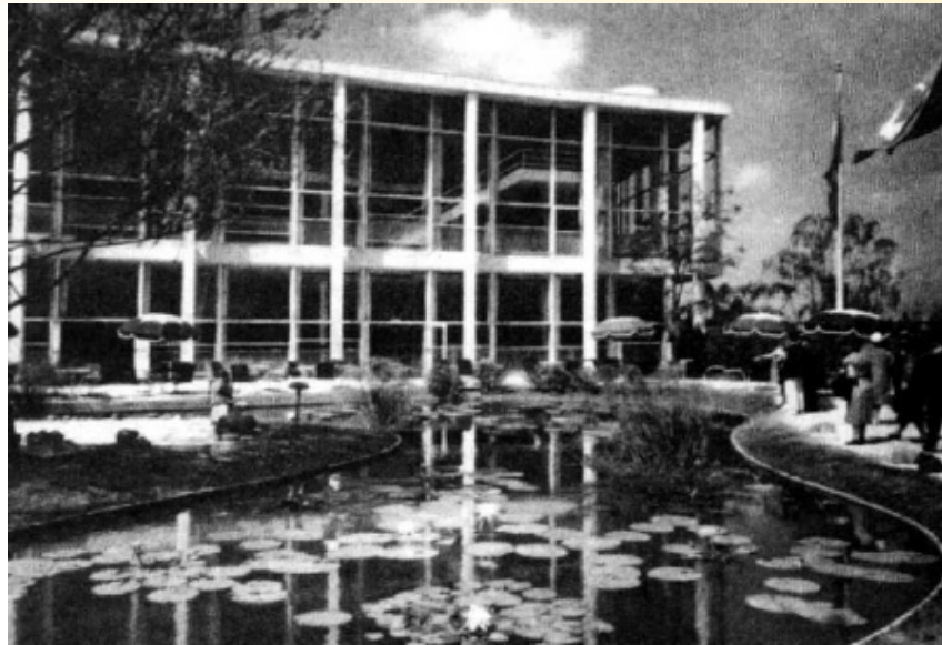
FIGURA 76 - Jardins de Burle Marx - estrutura sobreposta à cortina de vidro e caixilharia de aço, como no salão de exposições do Ministério;
