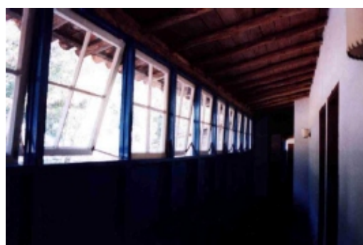
FIGURA 105 - circulação a sul, com "janela em fita", relatável às janelas contínuas de treliças da arquitetura colonial.
