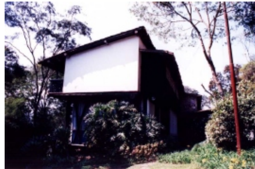
FIGURA 91 - Foto de 99; o prédio tido como provisório, encontra-se em bom estado sem ter tido maiores manutenções. A empena situa-se a W-WS. Embaixo os quebra-sol verticais e de madeira.
