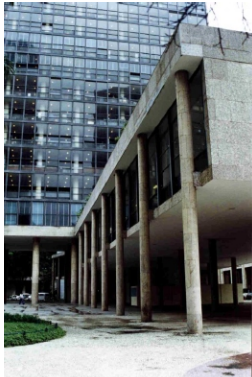
FIGURA 48 - Outra visão da colunata do salão de exposições com o encabeçamento reto;
