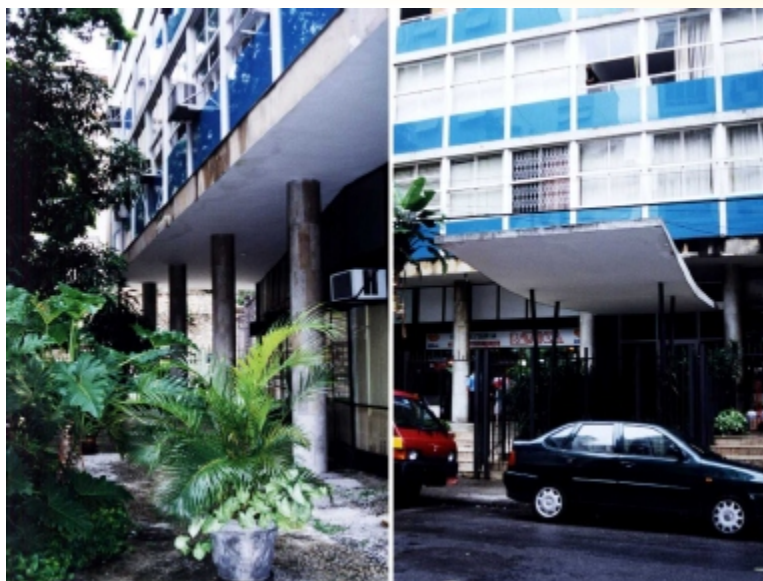
FIGURA 134 - Detalhe do pilotis e do fechamento que desvia-se abrindo para o portal de entrada; detalhe do átrio em laje sinuosa - da leveza de sua obra e das geometrias livres, temas sempre recorrentes;
