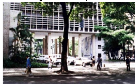
FIGURA 58 - Outra visão mostrando o pórtico de passagem, o caminho induzido através do pilotis;
