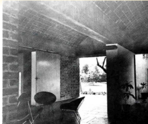
FIGURA 26 - Casa Sarabhai em Ahmedabad na Índia (1955). Foto do interior com as abóbadas catalãs - soluções tecnológicas: de conforto ambiental na orientação para captar ventos dominantes e fachadas com quebra-sol aplicadas em sintonia com as soluções do sistema estrutural que combina as abóbadas em semi-cilindro apoiadas em vigas e pilares de concreto armado; o jogo arquitetônico é feito a partir desses elementos combinando cheios e vazios, uma nova versão da planta livre;
