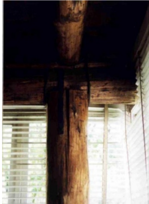
FIGURA 98 - Estrutura de toras - detalhe com a ferragem de amarração do encontro de peças. As venezianas de madeira em branco, suavizando a luminosidade de leste e norte.
