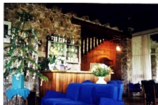
FIGURA 118 - por outro ângulo com a interrupção da alvenaria com a verga em toras e a escada ao fundo;
