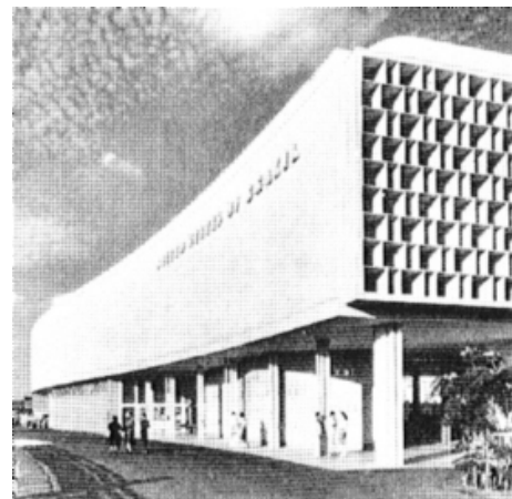
FIGURA 78 - Os elementos vasados, protetores do sol, na fachada sul e a curva da fachada lateral.
