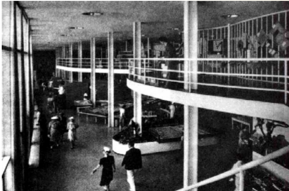
FIGURA 75 - Tema recorrente, a sinuosidade incorpora-se à linguagem modernista brasileira; A estrutura ganha uma versão em perfis de aço; a laje curva evoca o traçado livre da dualidade racionalismo e natureza; permanece a continuidade dos tetos - a ênfase na distinção dos elementos;
