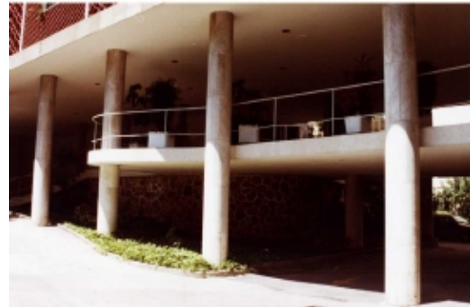
FIGURA 131 - O pilotis, aqui com usos variados. Teto plano obtido através de laje cogumelo invertida, a exemplo do "Ministério";
