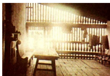
FIG. 34 - Aberturas opostas que propiciam correntes de ventilação. Varanda posterior do Engenho São Joaquim - proximidades de Pirinópolis em Goiás;
