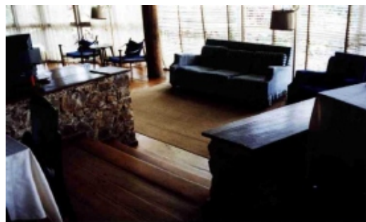
FIGURA 101 - Detalhes demonstrando os acabamentos: piso em tábuas de pinho e mureta em pedra.
