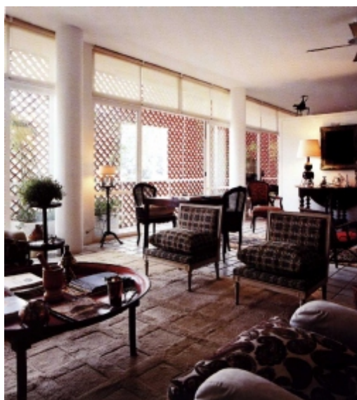
FIGURA 138 - Ambiente da sala mostrando a estrutura independente, o fechamento em vidro e a "cortina" de cobogós.
