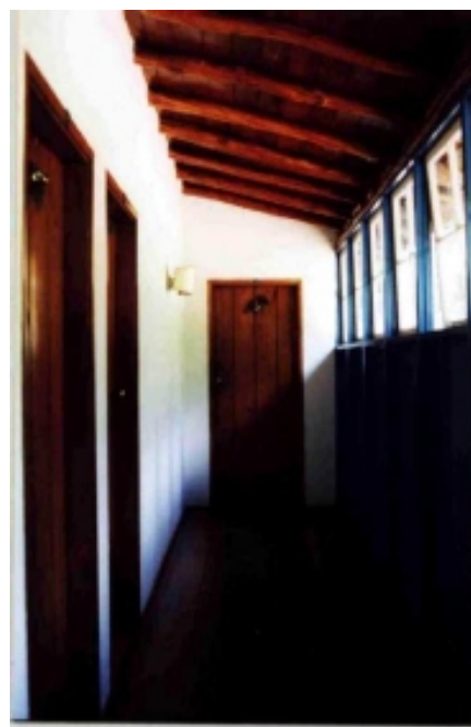
FIGURA 106 - circulação tipo balcão, a partir do balanço das nervuras de madeira, e fechamento leve, em tábuas, e em azul, cor das esquadrias coloniais;
