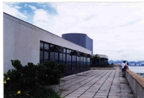
FIGURA 68 - O terraço com as "chaminés" de desenho curvo e a incrível visão da baía da Guanabara;
