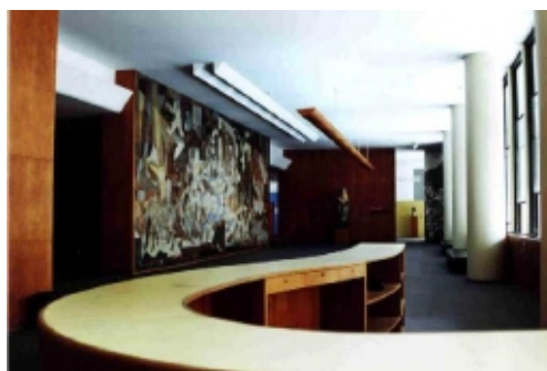
FIGURA 66 - Interior com a estrutura descolada do fechamento em caixilhos de aço e vidro - o balcão curvo e o painel de Cândido Portinari;
