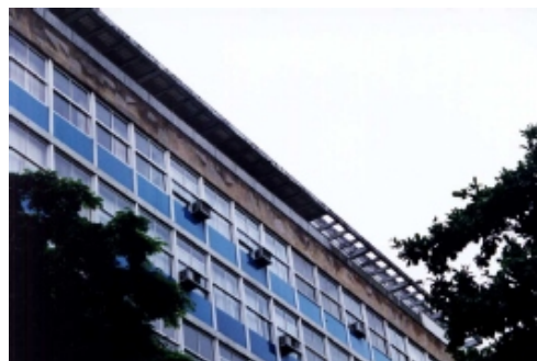
FIGURA 136 - Detalhe das esquadrias com vidro azul (era outro azul originalmente) e o encabeçamento do prédio em pérgulas vazadas e fechadas;
