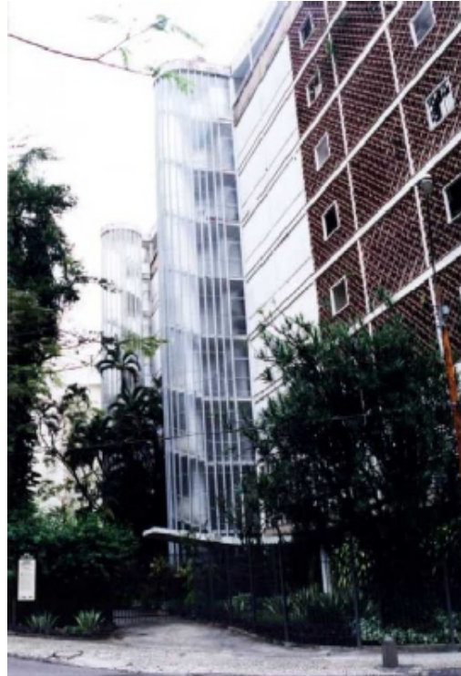
FIGURA 122 - Composição com as torres de escadas e o mosaico de elementos vazados;
