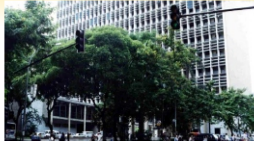
FIGURA 60 - Outra visão da elevação norte com os “quebra-sol”;
