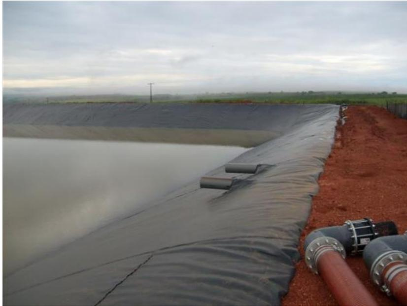
Figura 98: Ilustração do tanque de contenção de rejeito perigoso.
