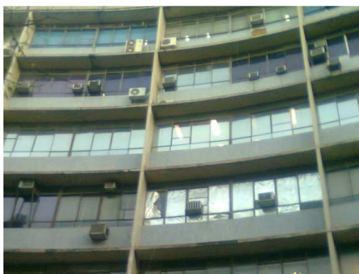
Figura 5.1: Situação atual da fachada norte
