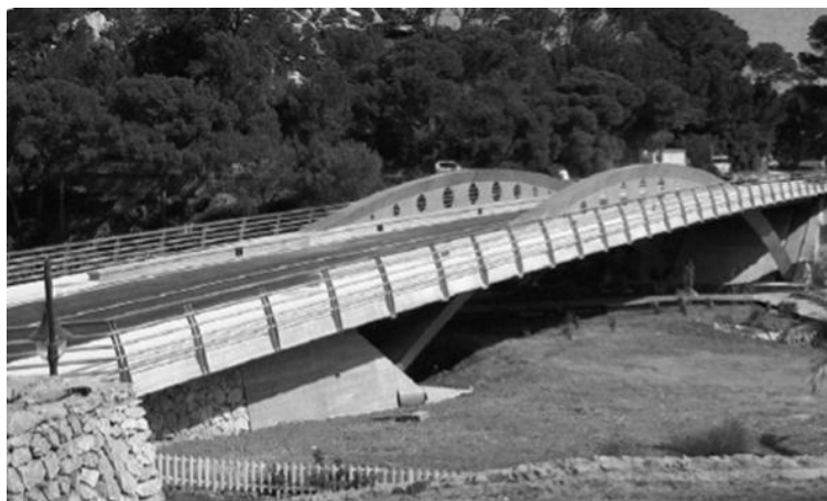
Figura 3 ponte construída com SDSS 2205 na Suécia (OLSON et. al., 2008).
