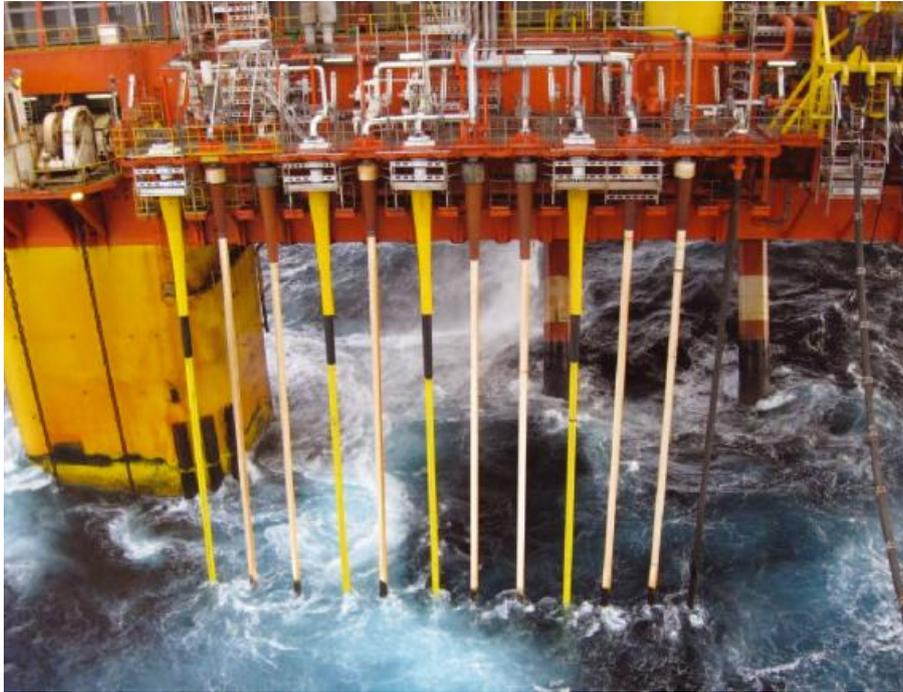
Figura 5 - Aplicação externa de *Bend Stiffeners*.
