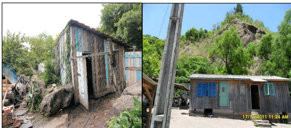
Figuras 8 e 9 - Blocos de rocha decorrente de queda próximo de residência, e residências próximas de antiga área de mineração da prefeitura, Igrejinha - RS.
