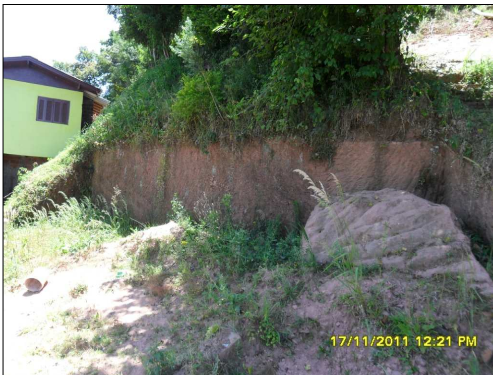
Figura 24 - Corte realizado na base do morro, para construção de uma nova residência, município de Igrejinha - RS.
