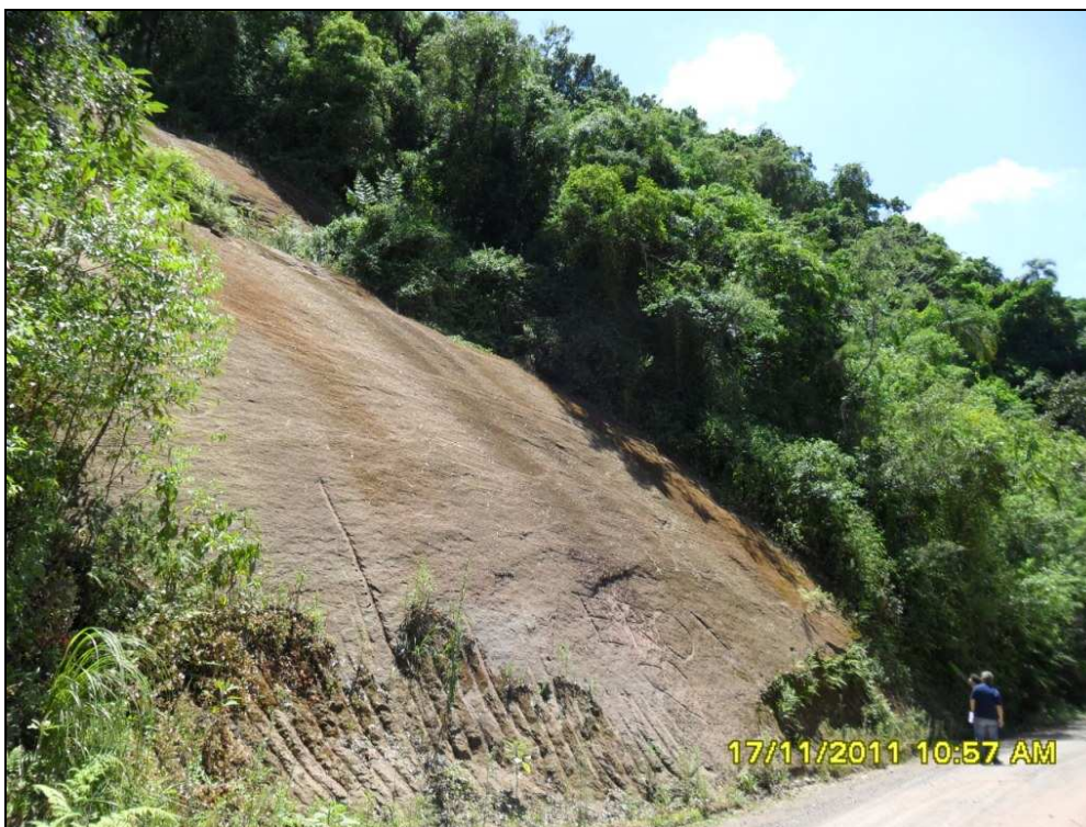
Figura 23 - Área de deslizamento em substrato rochoso, divisa dos municípios de Igrejinha e Três Coroas - RS.
