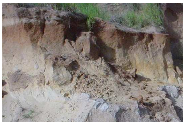
Figura 6.1 – Foto do corte do terreno mostrando a variação de cor e possível alteração das areias com a profundidade.
