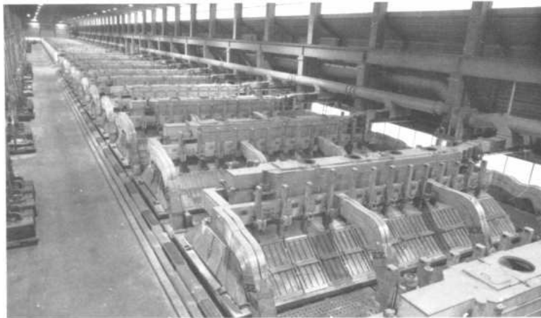
Figura 2: Linha de cubas atual de aproximadamente 280 KA (Gjortheim, K. et al. ,1988).
