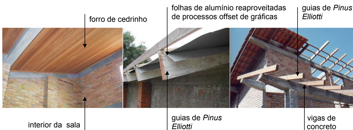
Figura 23: detalhes do subsistema A
