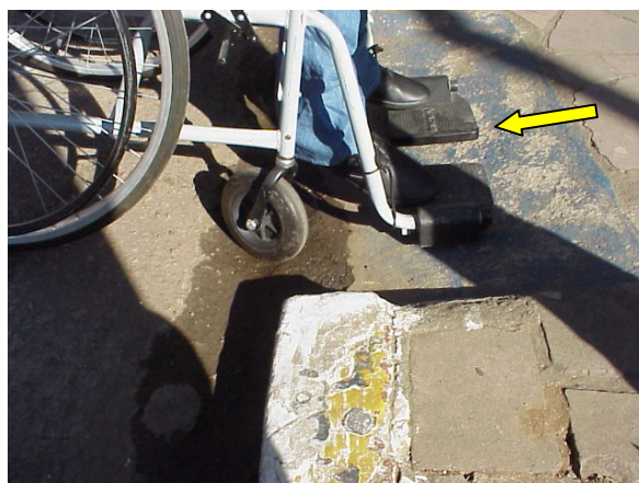
Figura 20. Pequenas valas entre a pista e a rampa fazem com que a cadeira de rodas tranque o suporte de pés, impedindo a subida.
