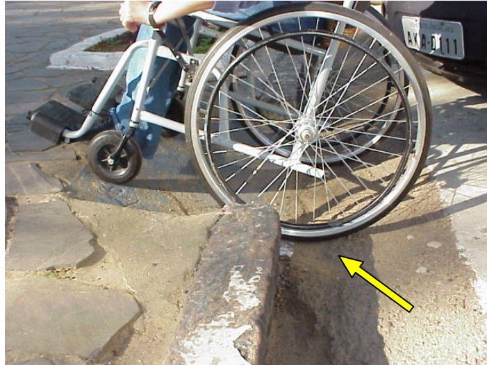
Figura 21. Buracos junto ao meio fio impedem o acesso da cadeira, que tranca ao subir.
