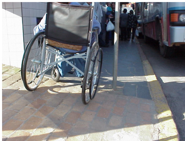
Figura 25. Excessiva declividade lateral, calçada estreita e obstáculos no caminho fazem a inacessibilidade do cadeirante ao ônibus urbano.
