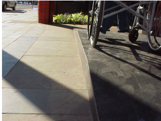
Figura 24. Exemplo de rampa sem segurança de borda.
