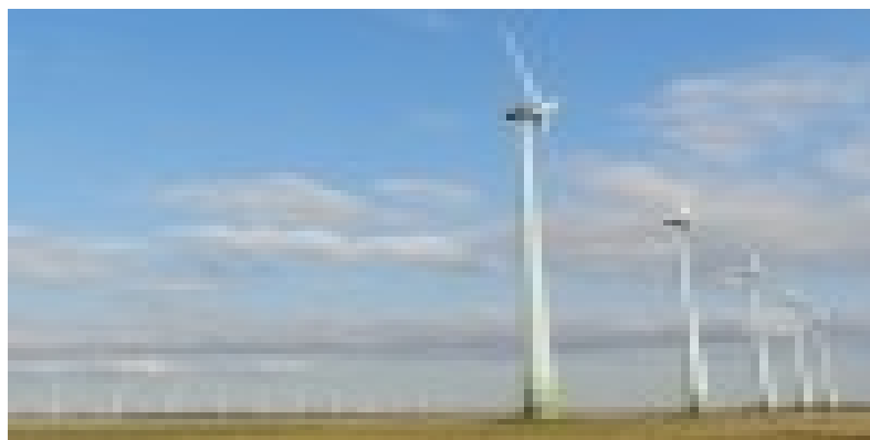
Figura 31: Fotografia do Parque Eólico situado na Cidade de Osório – RS
