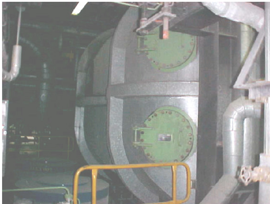
Figura 3.4 Condensador Casco – Tubo de Candiota II, Fase B.
