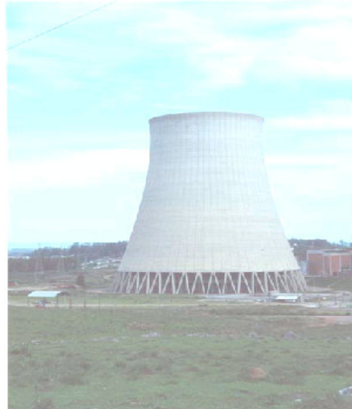
Figura 3.5 Torre seca de refrigeração da Fase B.
