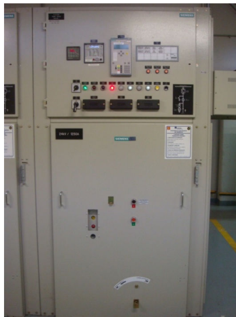
Figura 27 Cubículo 8BD1 da Siemens.
