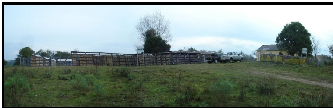
Figura 15 - Foto do galpão de testemunhos da empresa Amarillo Gold Corporation, em Lavras do Sul, RS.
