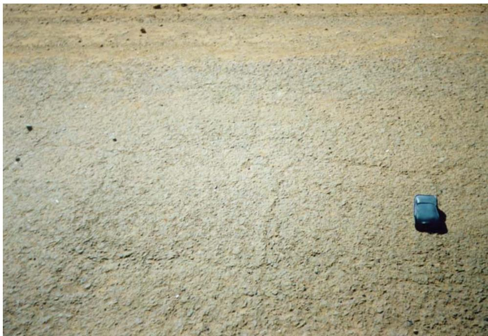
Figura 4.26 – Trincamento em bloco no revestimento
