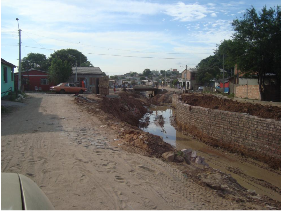
Fotografia 1 - Arroio José Joaquim numa região mais próxima à sua nascente. Conforme é possível visualizar, está recebendo obras de canalização, com a justificativa de conter as cheias.
