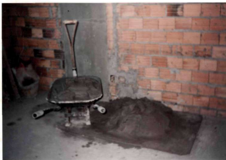
Figura 3.3.4-c - Argamassa de revestimento externo sobre folha de madeira compensada.
