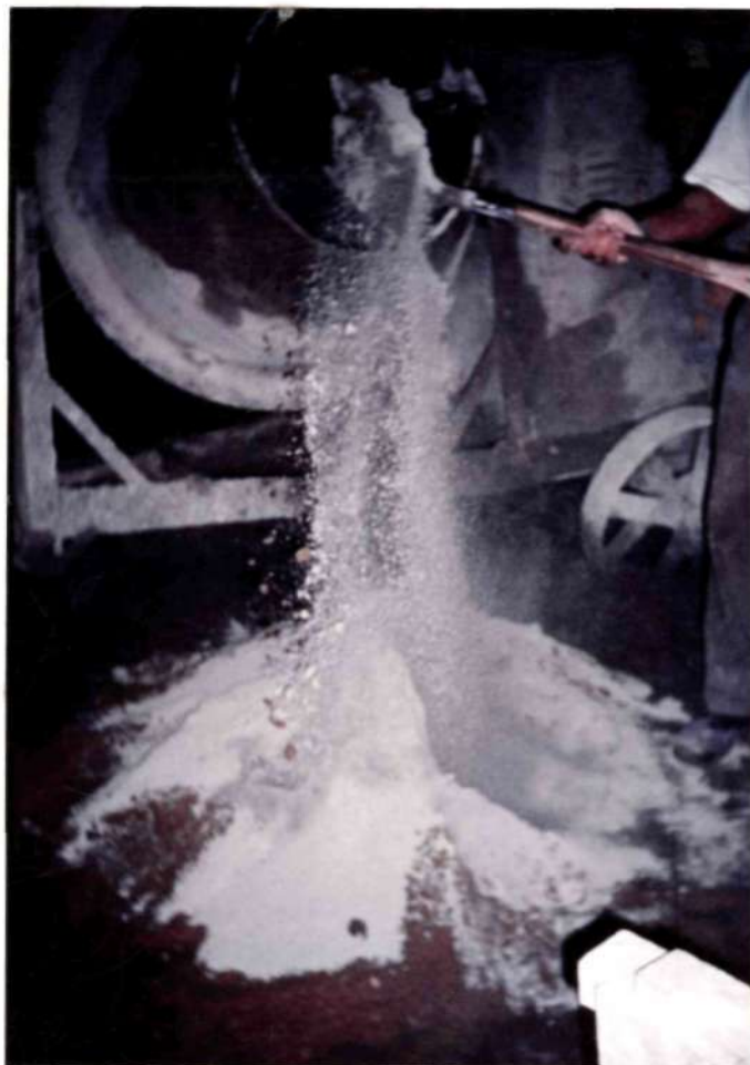
Figura 3.3.7-a - Procedimento de dosagem de uma empresa do grupo I; primeiramente o material (cimento, cal e areia) era amontado em frente à betoneira e depois colocado no seu interior com pá.
