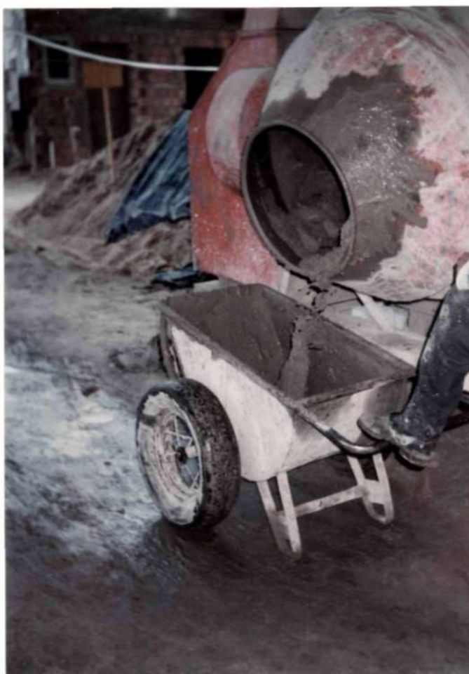
Figura 3.3.8-a - Carro de transporte de argamassa denominado de "jirica".
