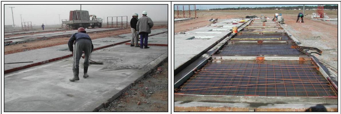
Figura 32: unidade de pré-fabricação de painéis no canteiro
