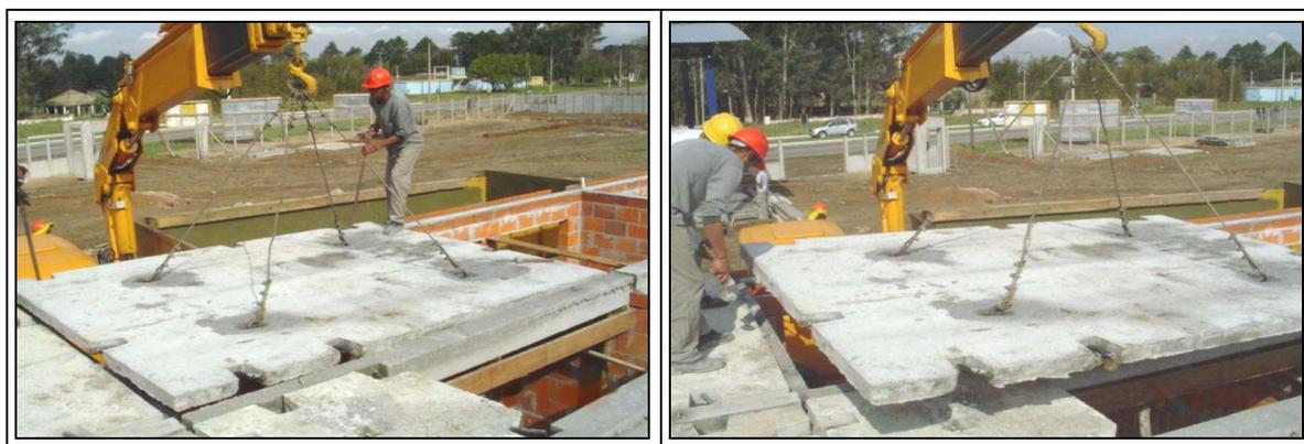
Figura 47: processo de montagem das lajes
