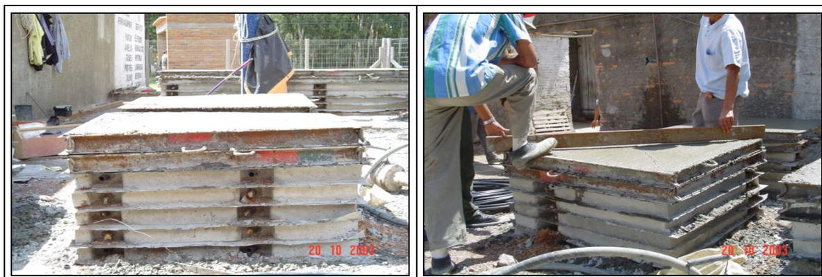
Figura 51: produção de lajes fora da unidade de pré-fabricação
