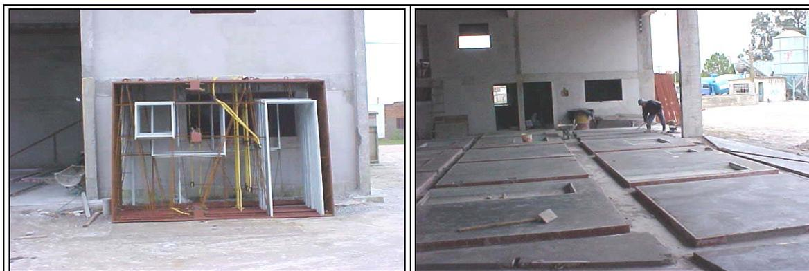
Figura 18: execução dos painéis pré-fabricados
