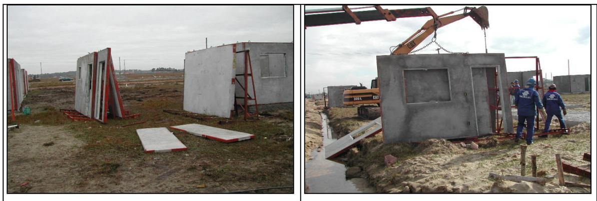
Figura 34: inadequação da organização dos painéis ao processo de montagem
