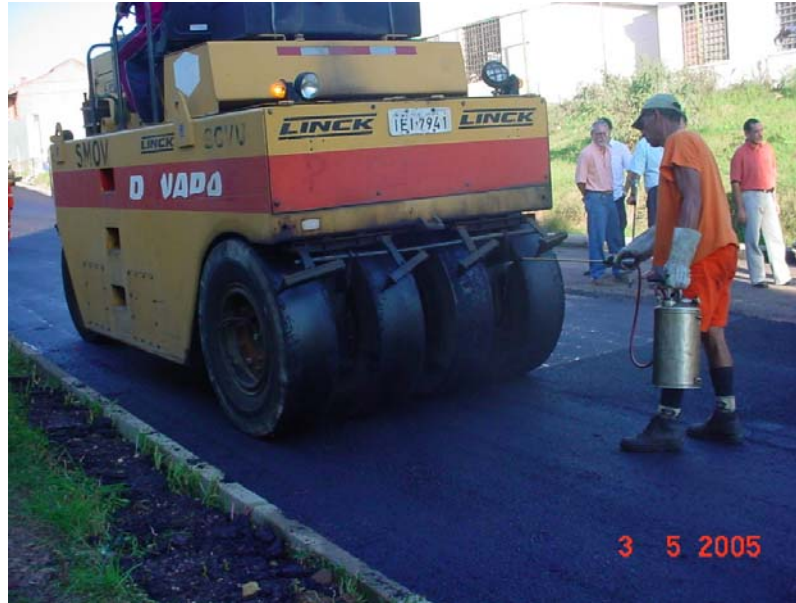
Figura 54: Compactação da massa na pista com rolo pneumático
