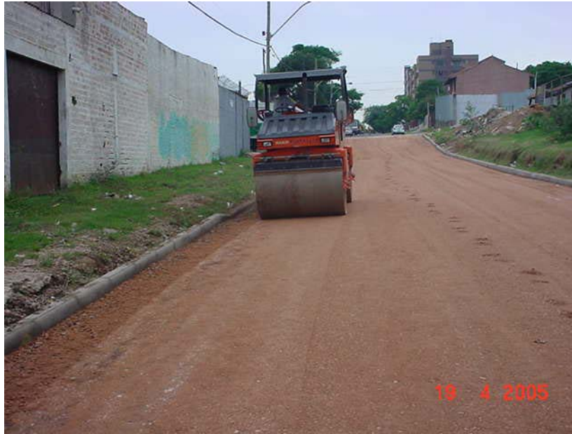
Figura 38: Compactação da base de brita graduada
