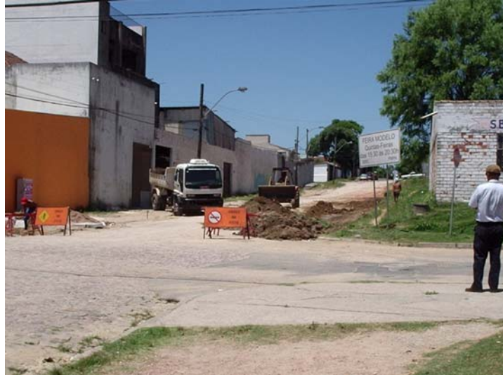
Figura 36: Execução da terraplenagem
