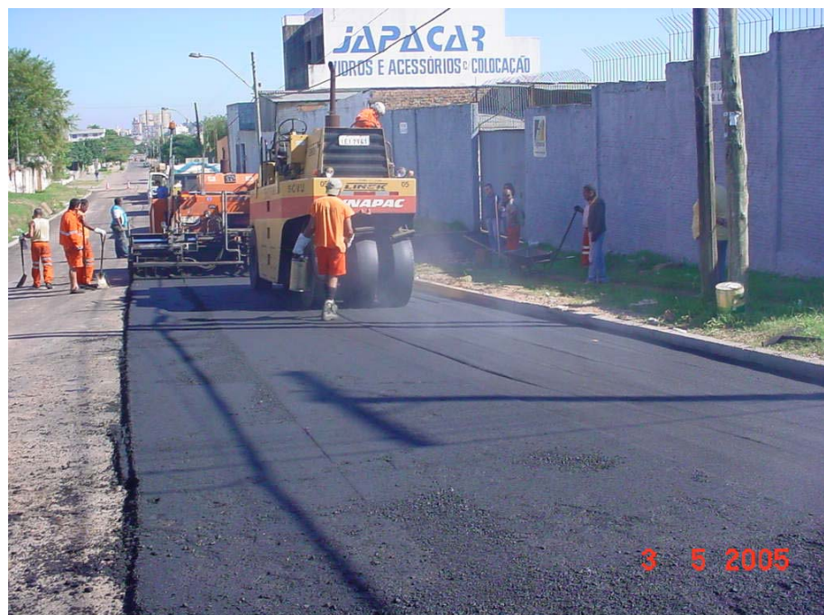
Figura 45: Execução do trecho com concreto asfáltico convencional
