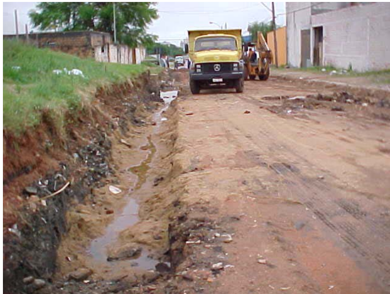
Figura 34: Execução de vala para assentamento das tubulações da drenagem superficial
