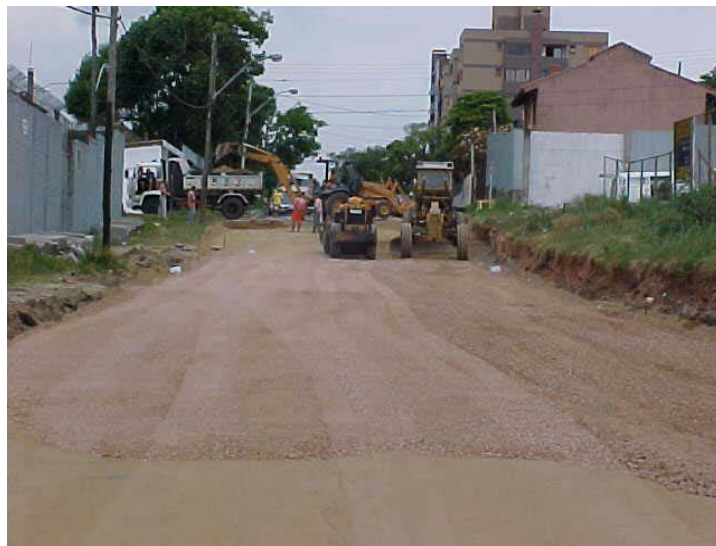
Figura 37: Execução da base de brita graduada
