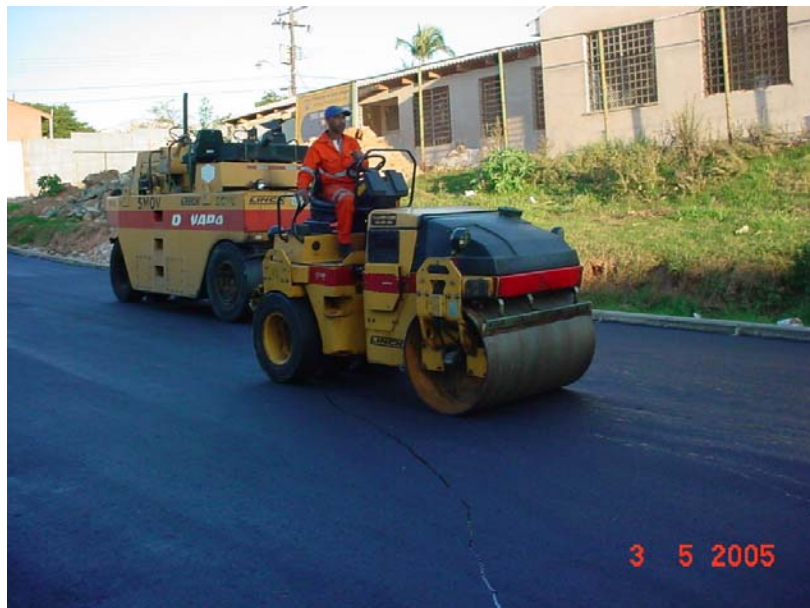
Figura 55: Compactação com rolo tandem, com cilindro em chapa de aço
