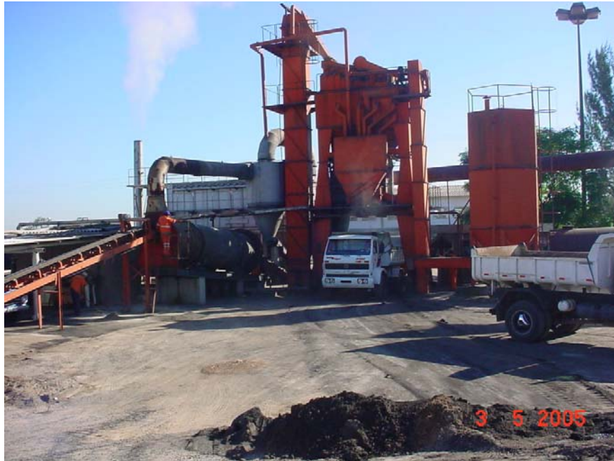
Figura 43: Vista panorâmica da usina gravimétrica
