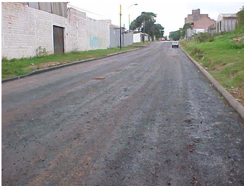
Figura 40: Uma vista do trecho com a base executada, imprimada e com os meios-fios
