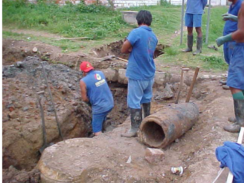
Figura 35: Colocação dos tubos da drenagem superficial
