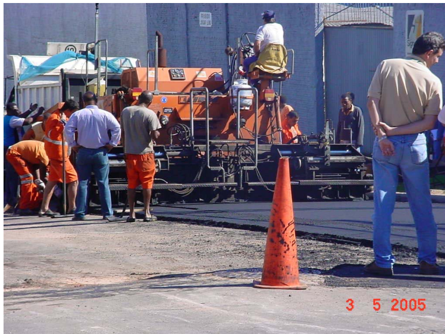
Figura 44: Execução do trecho com concreto asfáltico convencional
