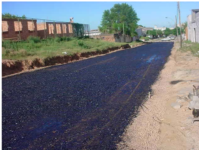
Figura 39: Base imprimada
