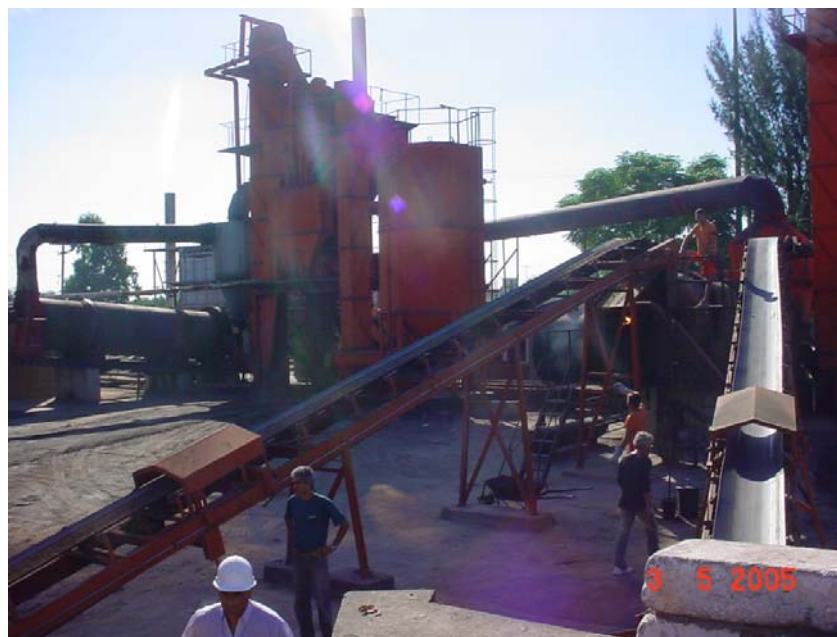
Figura 49: Vista panorâmica da usina volumétrica
