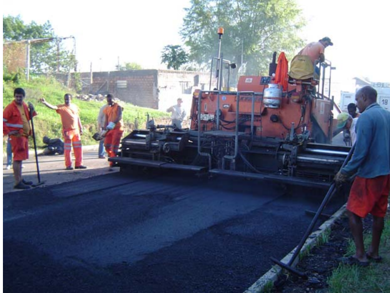
Figura 52: Execução do trecho com concreto asfáltico com incorporação de borracha de pneus
