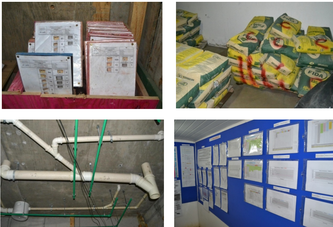
Figura 4: em sentido horário a partir do canto superior esquerdo: Sistema de kanban de alvenaria; Sistema de identificação First In First Out ; Pré-montagem dos kits hidráulicos; Sistema de gerenciamento visual do escritório
