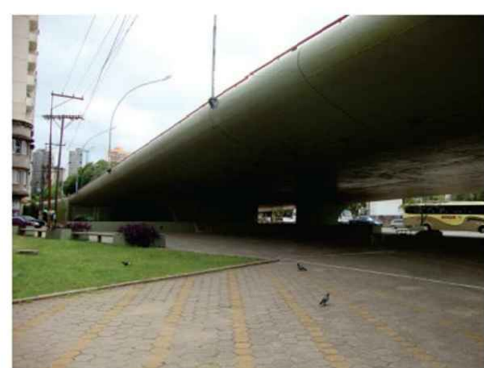
viaduto da av. João Pessoa
