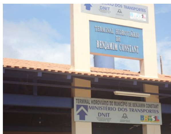
Figura 47: Terminal Hidroviário em BC
