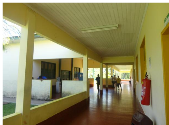
Figura 82: INC- Área interna – Prédio Antigo
