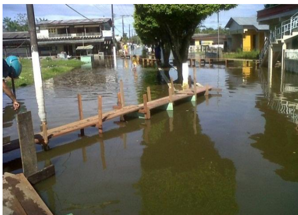
Figura 69: Rua inundada – tráfego em ponte
