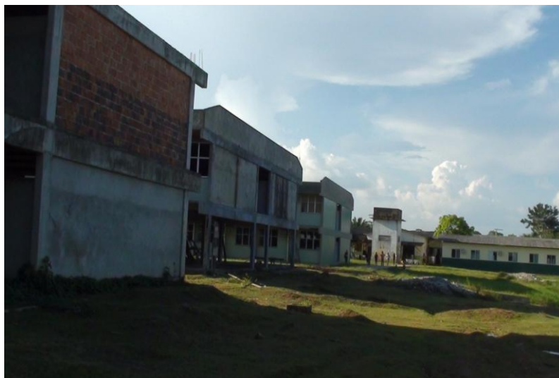
Figura 83: Prédios Novos e em construção
