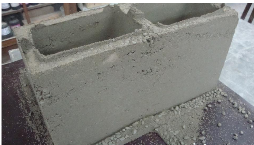
Figura 23 – Aspecto do bloco com teor de umidade em 4%
