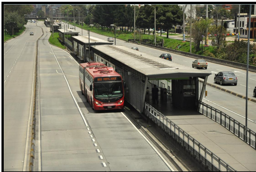
Figura 16 – Faixa de ultrapassagem nas estações em Bogotá/Colômbia
