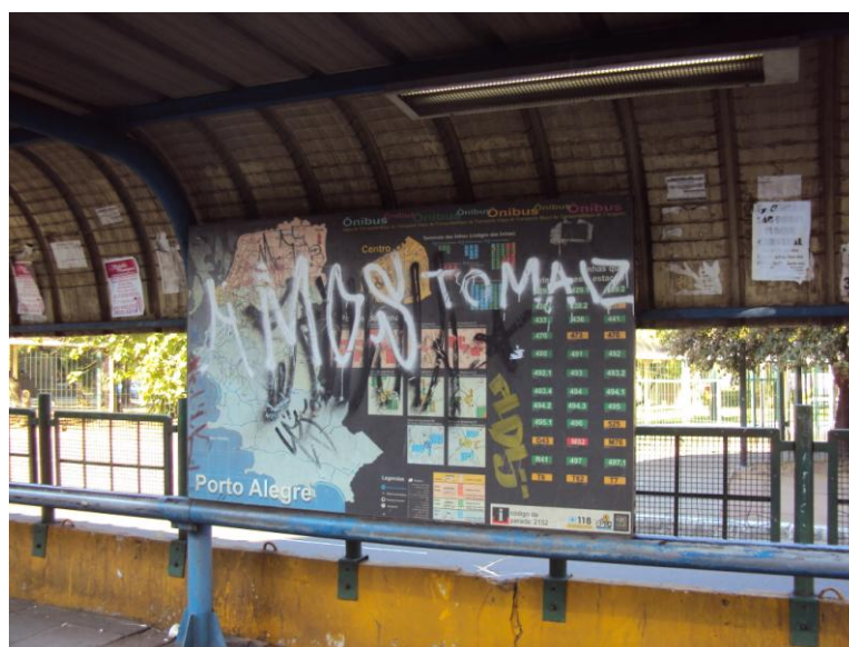
Figura 7 – Totem informativo completamente depredado
