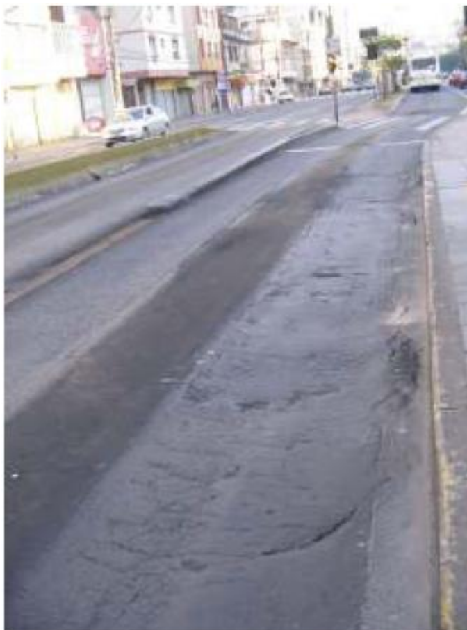
Figura 4 – Defeito conhecido como trilha de roda em corredor de ônibus situado em Porto Alegre
