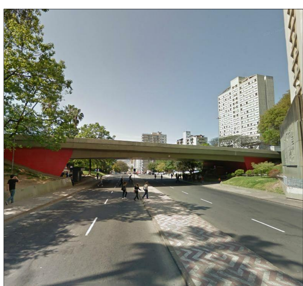
Viaduto Loureiro da Silva
