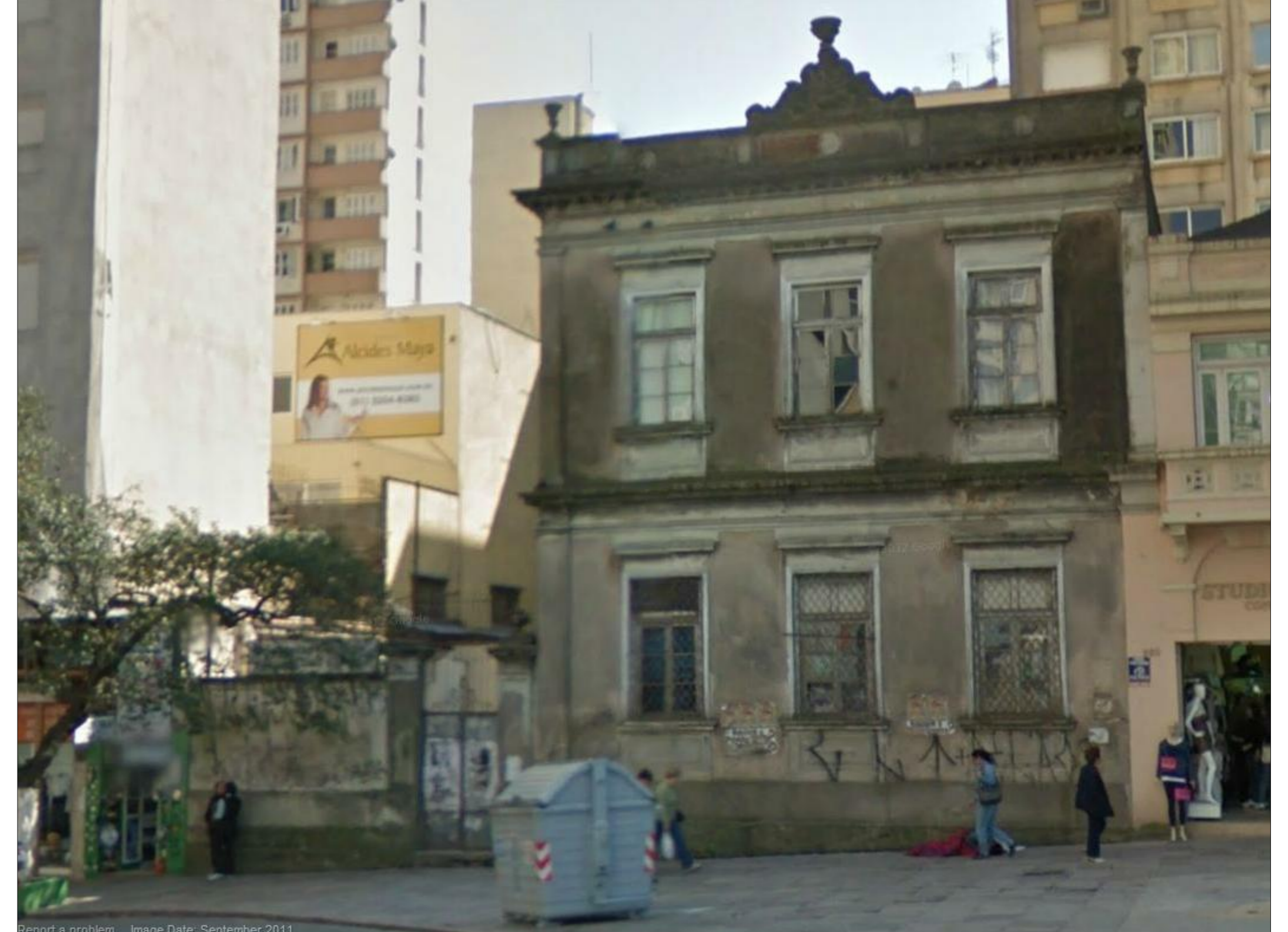
Fachada Av. Salgado Filho
