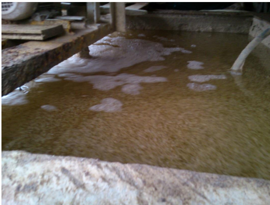
Figura 3.3: Floculação no tanque do tratamento terciário.
