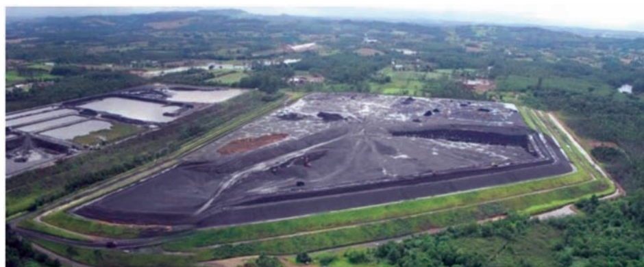
Figura 3 Vista superior do Módulo B de rejeitos da UM II - Criciúma S.A (centro) e as bacias de sedimentação utilizadas no tratamento da água de processo (esquerda).
