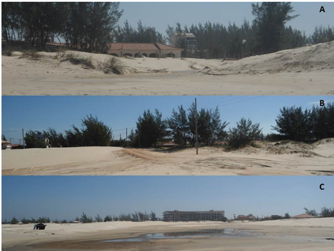
Figura 14: Ambiente de dunas do agrupamento de áreas significativamente degradadas. A) Trecho 1 com a urbanização substituindo as dunas e com plantio de C. equisetifolia para a contenção da areia; B) Trecho 2 com a colocação de saibro sobre as dunas para o acesso de veículos à praia; C) Trecho 4 com grandes áreas de sobrelavagem e paisagem degradada pelo uso antrópico.
