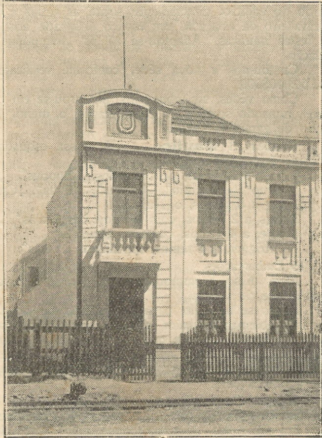
Séde propria, á Rua Voluntarios da Patria n.º 228 (FACHADA)
