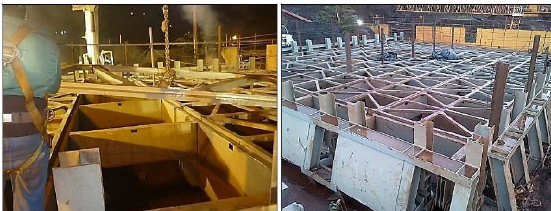
Figura 58 – Momentos de montagem da grelha na planta de britagem BSM-4.
