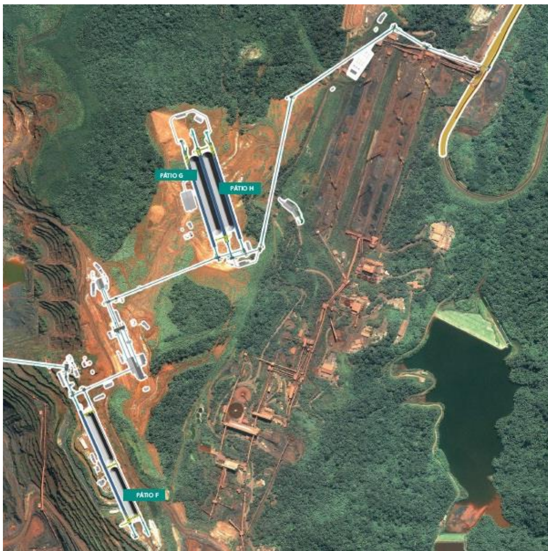
Figura 49 – Vista aérea das operações industriais de Carajás com indicação da localização da planta do +40 MTPA
