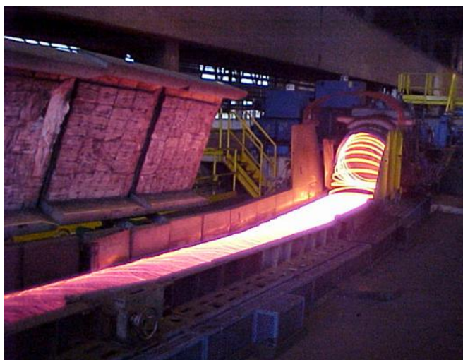
Figura 4.3 Visão geral do “cooling conveyor” com todas as capotas abertas e ventiladores ligados - condição utilizada no experimento.
