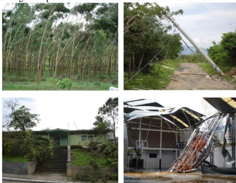
Figura 72. Danos gerado por um evento de downburst ocorrido em Cachoeira Paulista - SP
