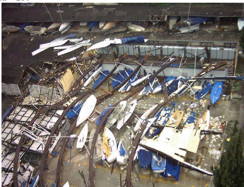
Figura 71. Foto dos danos estruturais ocasionados pelo evento de downburst ocorrido na represa de Guarapiranda – SP.
