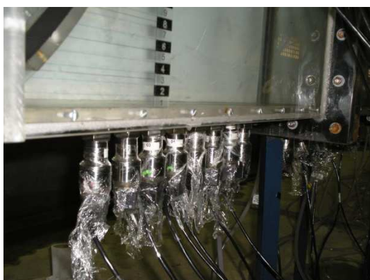
Figura 3.16 - Detalhe dos transdutores da base do conduto.
