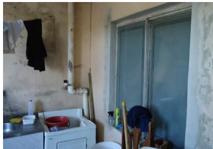
Vista 1: da janela do dormitório 2 no interior da lavanderia.
