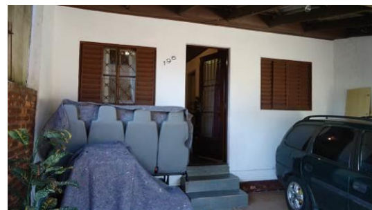
Vista interna do caso CS6: Telhas opacas e muro mais baixo somente em uma das laterais.
