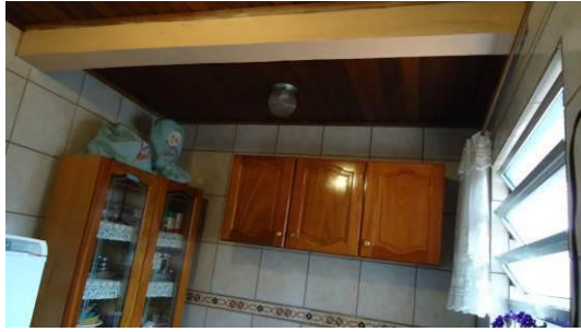
Viga onde ficava parede do banheiro original, onde espaço serviu para ampliar a cozinha do caso CS23.
