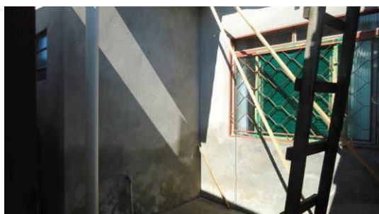
Figura 3.48 - Vista da janela do quarto dormitório no caso GB2.
