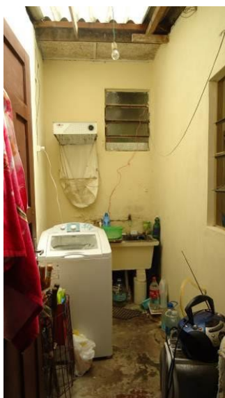
Vista da área de serviço entre as ampliações.
