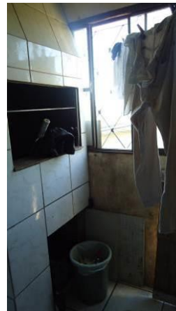
Vista 2: da janela da lavanderia para a área externa, que permite ventilação e iluminação indireta do dormitório 2 do caso CS3, o qual mudou de localização para servir de ampliação para a sala.
