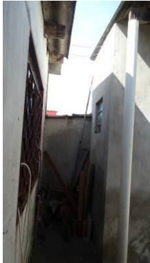
Vista das janelas da área de serviço (à esquerda) e do banheiro 4.
