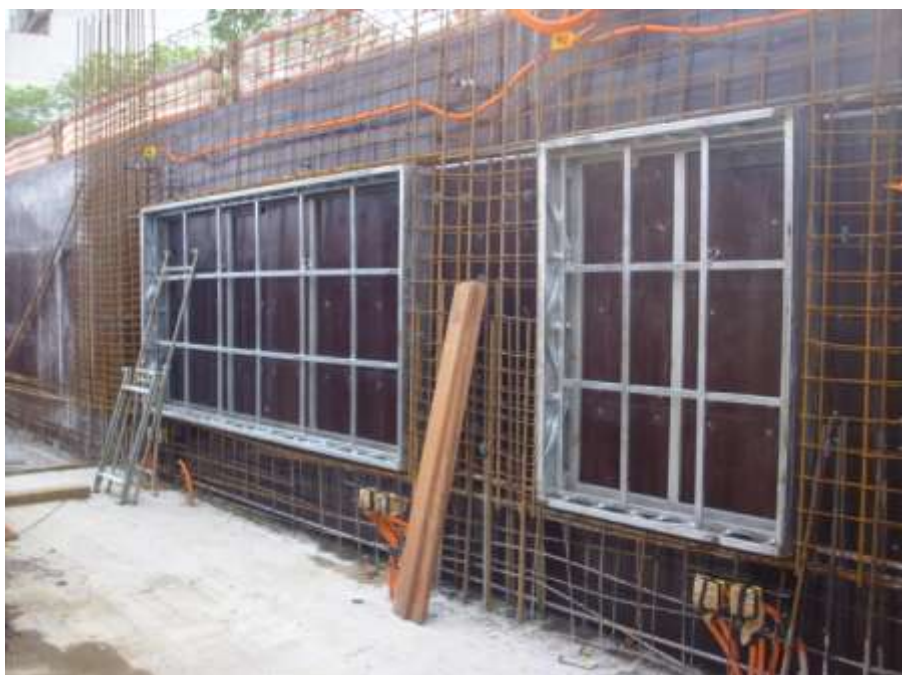
Figura 25 – Montagem da armadura de paredes
