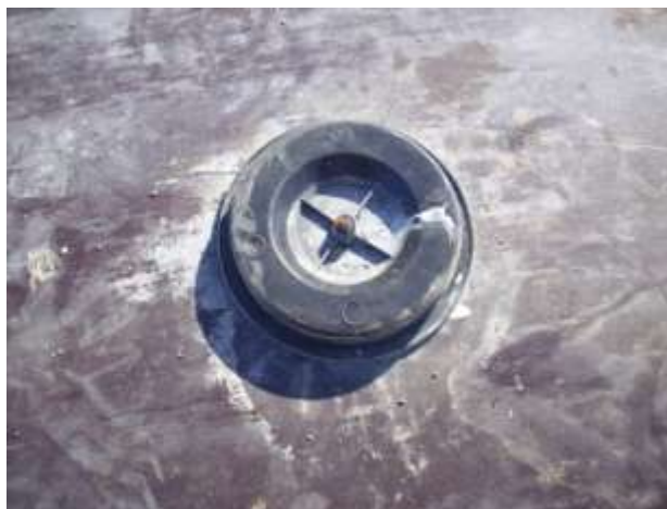
Figura 30 – Fixação da tampa da caixa elétrica no assoalho
