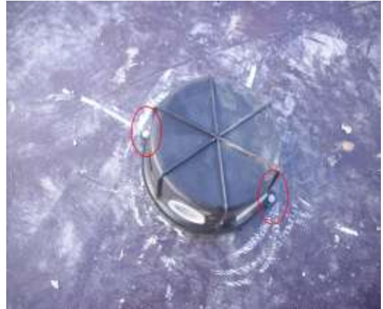
Figura 16 – Caixa elétrica plástica posicionada na fôrma
