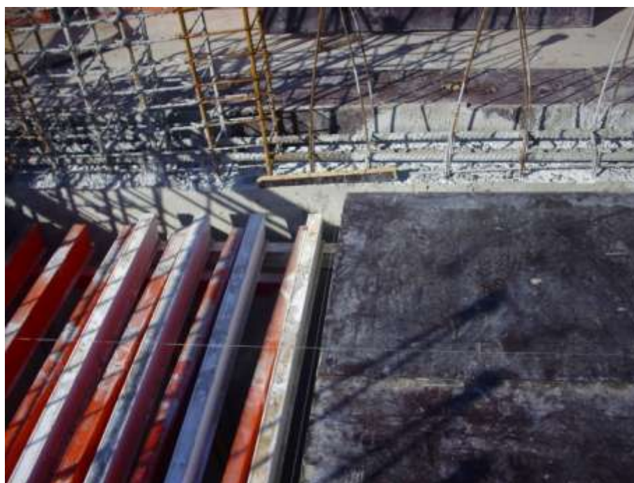
Figura 26 – Posicionamento das chapas de compensado com auxílio de linhas de nylon para paginação
