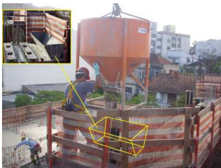
Figura 24 – Concretagem de pilares
