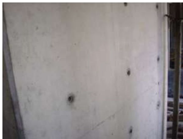
Figura 8 – Acabamento nos pilares dado pelo espaçador tipo cone 3/4
