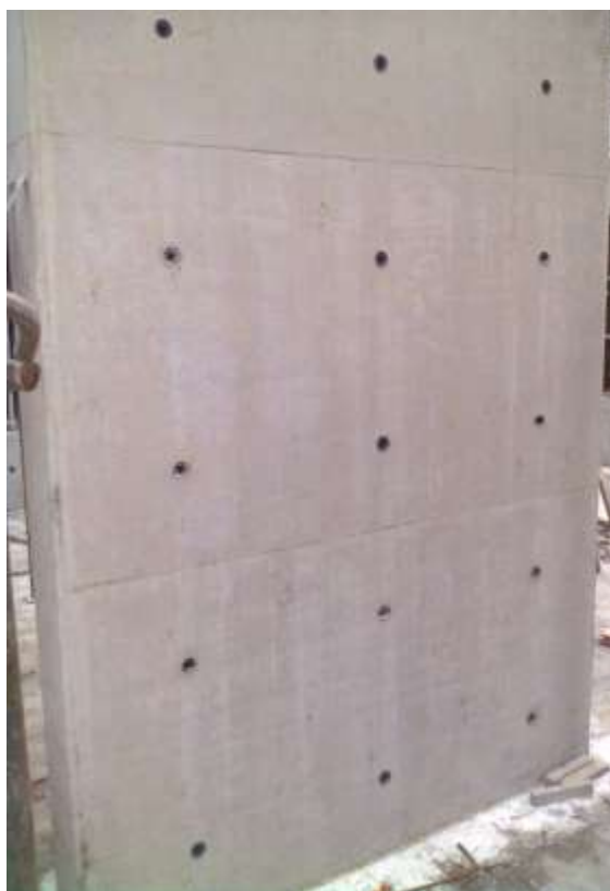
Figura 44 – Acabamento superficial ideal de um pilar
