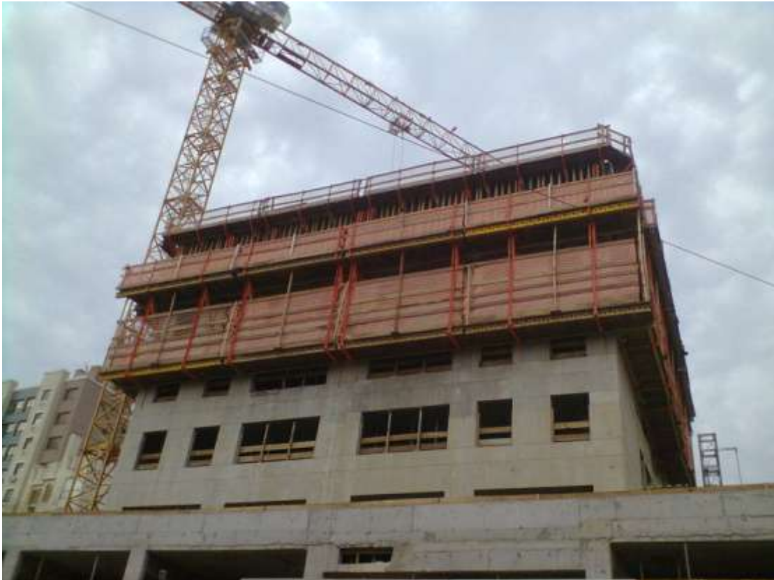
Figura 19 – Vista da fôrma autotrepante envolvendo a edificação
