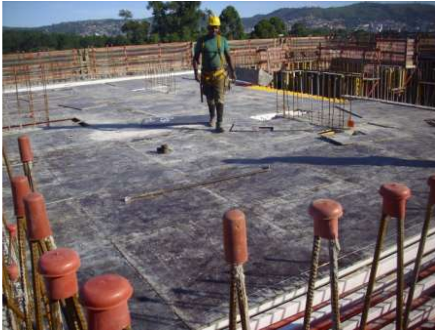
Figura 11 – Vista geral do assoalho paginado em compensado plastificado após a terceira utilização
