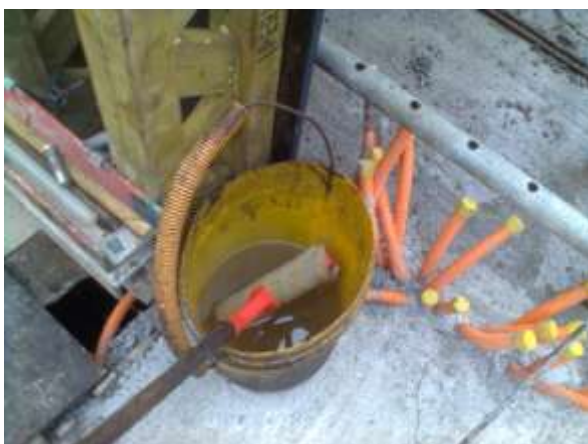
Figura 13 – Desmoldantes emulsão em óleo para pilares e paredes
