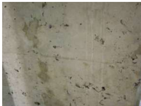
Figura 35 – Grande concentração de vazios em um pilar
