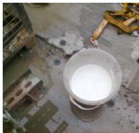
Figura 14 – Desmoldante emulsão em água para lajes
