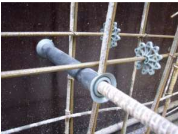
Figura 7 – Espaçador tipo cone 3/4 e circular
