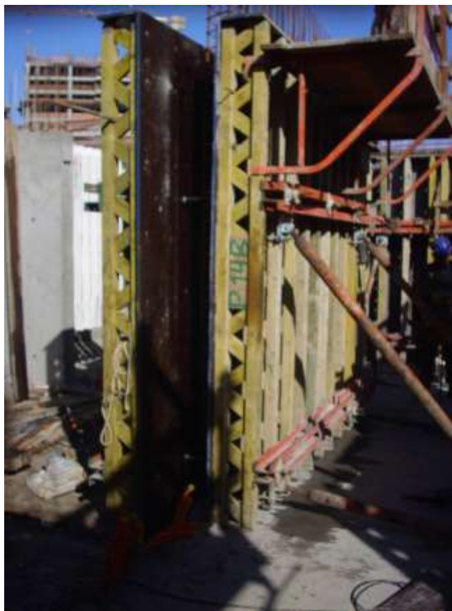
Figura 23 – Montagem da fôrma dos pilares
