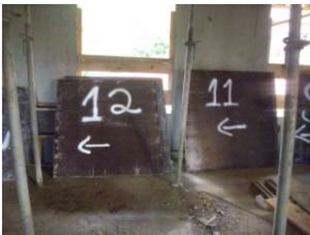
Figura 28 – Identificação das chapas de compensado
