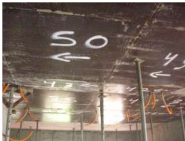
Figura 29 – Fôrma da laje reescorada
