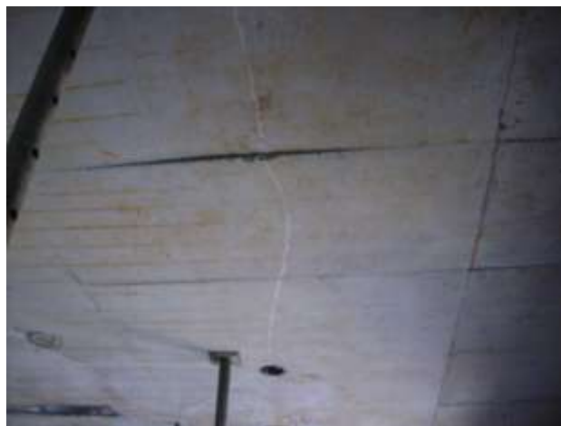
Figura 43– Juntas desniveladas
