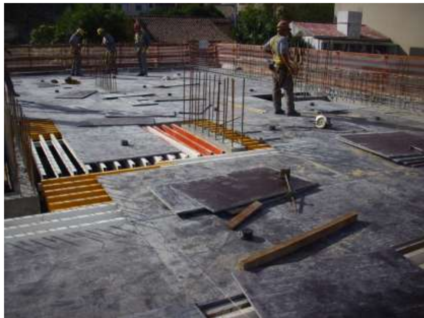
Figura 10 – Vista Geral do assoalho paginado em compensado plastificado após a primeira utilização
