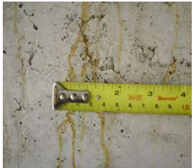
Figura 32 – Detalhe da incidência de bolhas
