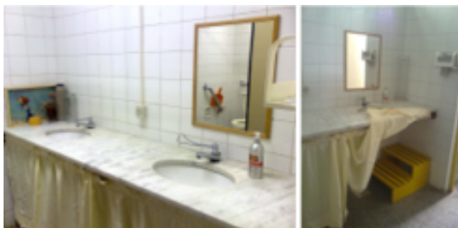
Figura 24: Pias com torneiras com alavancas e escada de madeira (Fonte: Arquivo pessoal).
