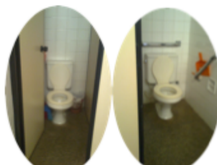
Figura 23: Sanitários da SIR. (Fonte: Arquivo pessoal).
